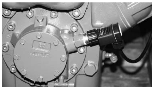
Масляный насос с датчиком INT 250 oil pump with INT 250 pressure switch
